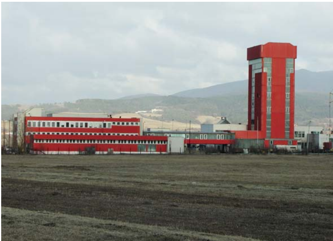
30. júla 2009 špecialisti Hlavnej banskej záchranej stanice v spolupráci firmou Demolex Košice odstrelom poslali do histórie G-jamu v Koši.
