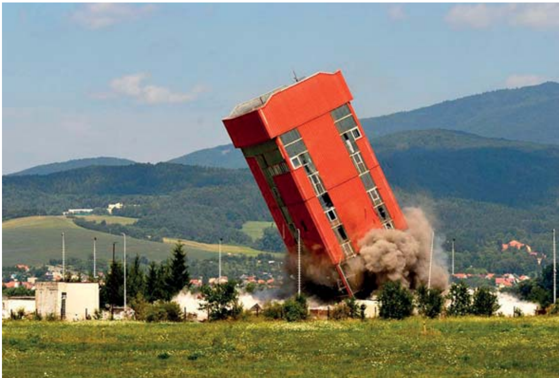
Oceľová konštrukcia G-jamy vážila 137 ton. Na odstrel bolo použitých 24 kg trhavy Danubit Geofex 2.
