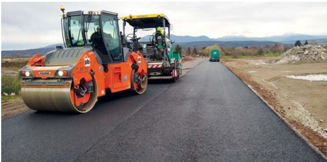
Pokládka asfaltovej zmesi na štátnej ceste 3. triedy č. III/1773, ulica Nová v Koši.
