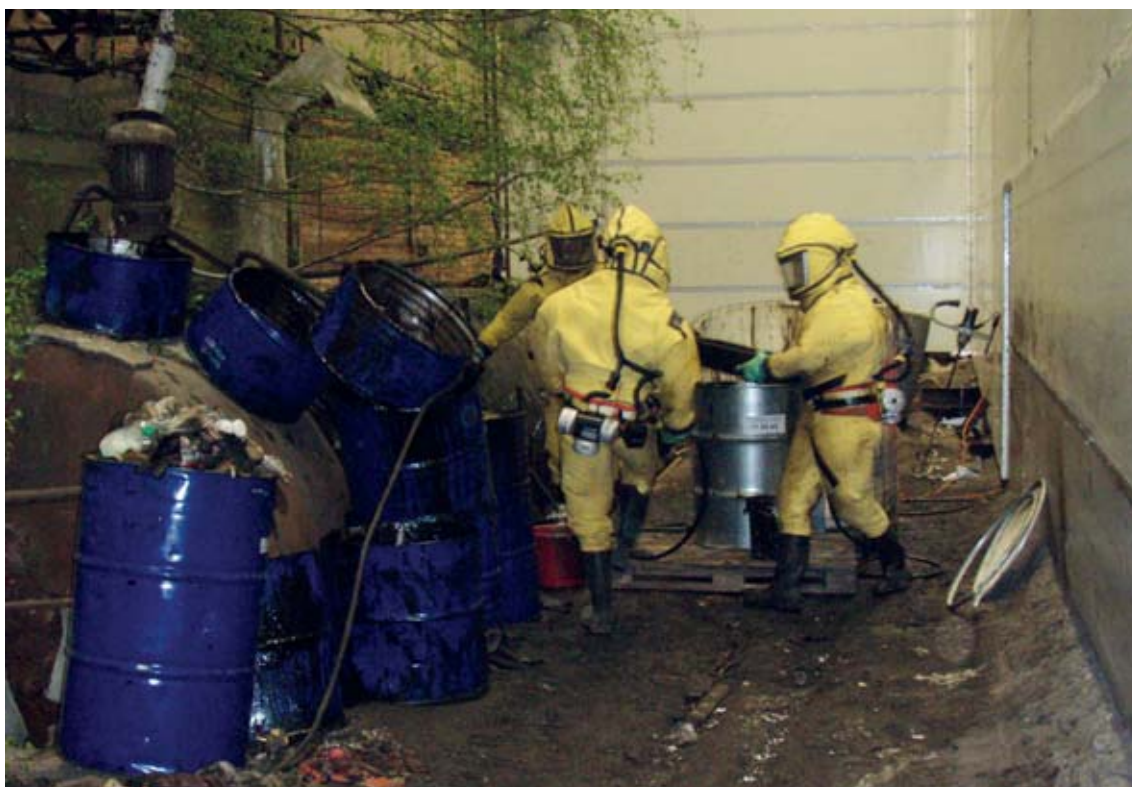
Likvidácia dioxínov znamenala prácu v zdraví škodlivom prostredí, blízku banskému záchranárstvu. Záchranári z HBZS Prievidza ju vykonávali v protichemických izolačných oblekoch vybavených diaľkovým prívodom vzduchu, chladením a kamerovým systémom. Ich úlohou bolo všetok kontaminovaný materiál dodávať pre dekontaminačnú linku.
