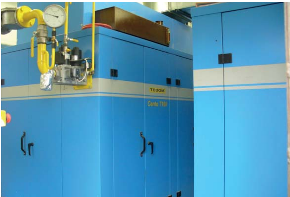
18. apríla 2007 bola uvedená do skúšobnej prevádzky degazácia vo Východnej šachte Handlová. Na snímke sú kogeneračné jednotky.
