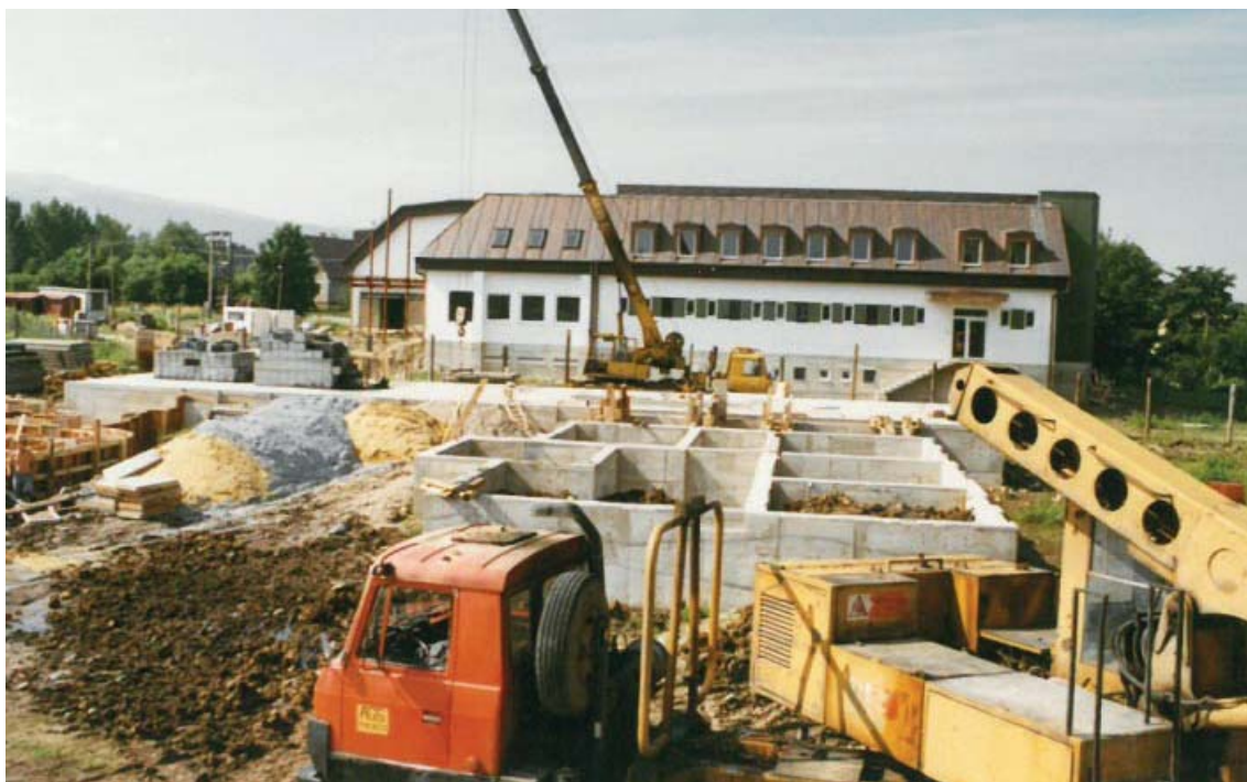
Realizátorom stavby košského kostola bola firma AGS Prievidza. Z celkových nákladov na stavbu 22,8 miliónov Sk, v ktorých neboli zahrnuté náklady na vybavenie interiérov, prístupových ciest a parkových úprav, sa v roku 1997 malo preinvestovať 15 miliónov Sk.
