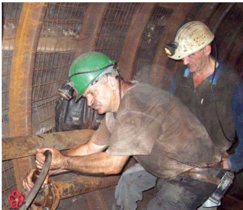
Kolektív Pavla Halašku bol vytvorený na zabezpečenie montáže a demontáže stenového porubu a zároveň rozbíhal nové pracoviská.
