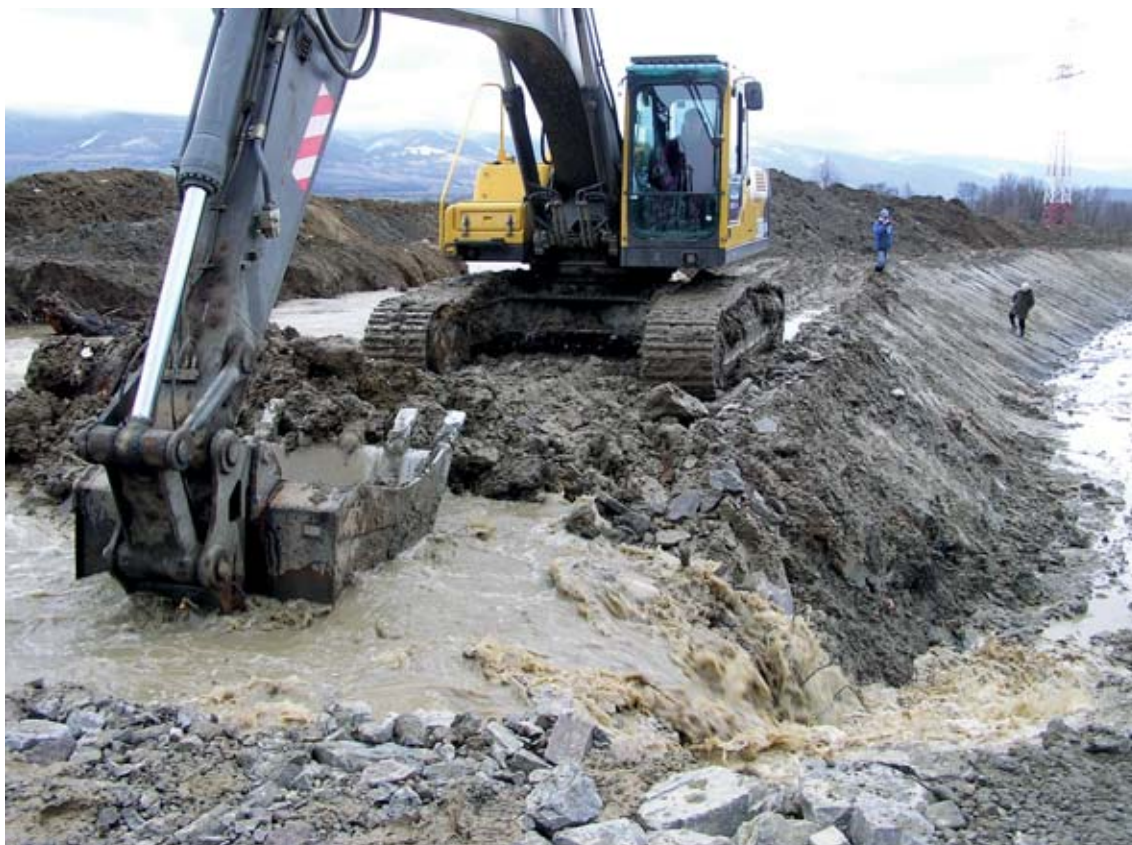
Presmerovanie koryta rieky Nitra 24. marca 2009 v súvislosti s prípravou novej ťažobnej kapacity 11. poľa ťažobného úseku Nováky.
