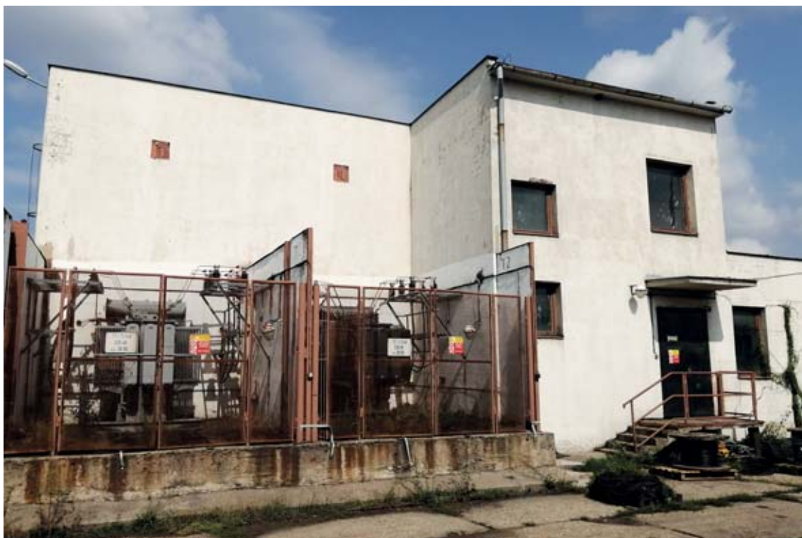
Dostatočné množstvo elektrickej energie pre baňu Čáry zabezpečoval nový VN prívod, ktorý bol uvedený do prevádzky 12. júna 2019.
