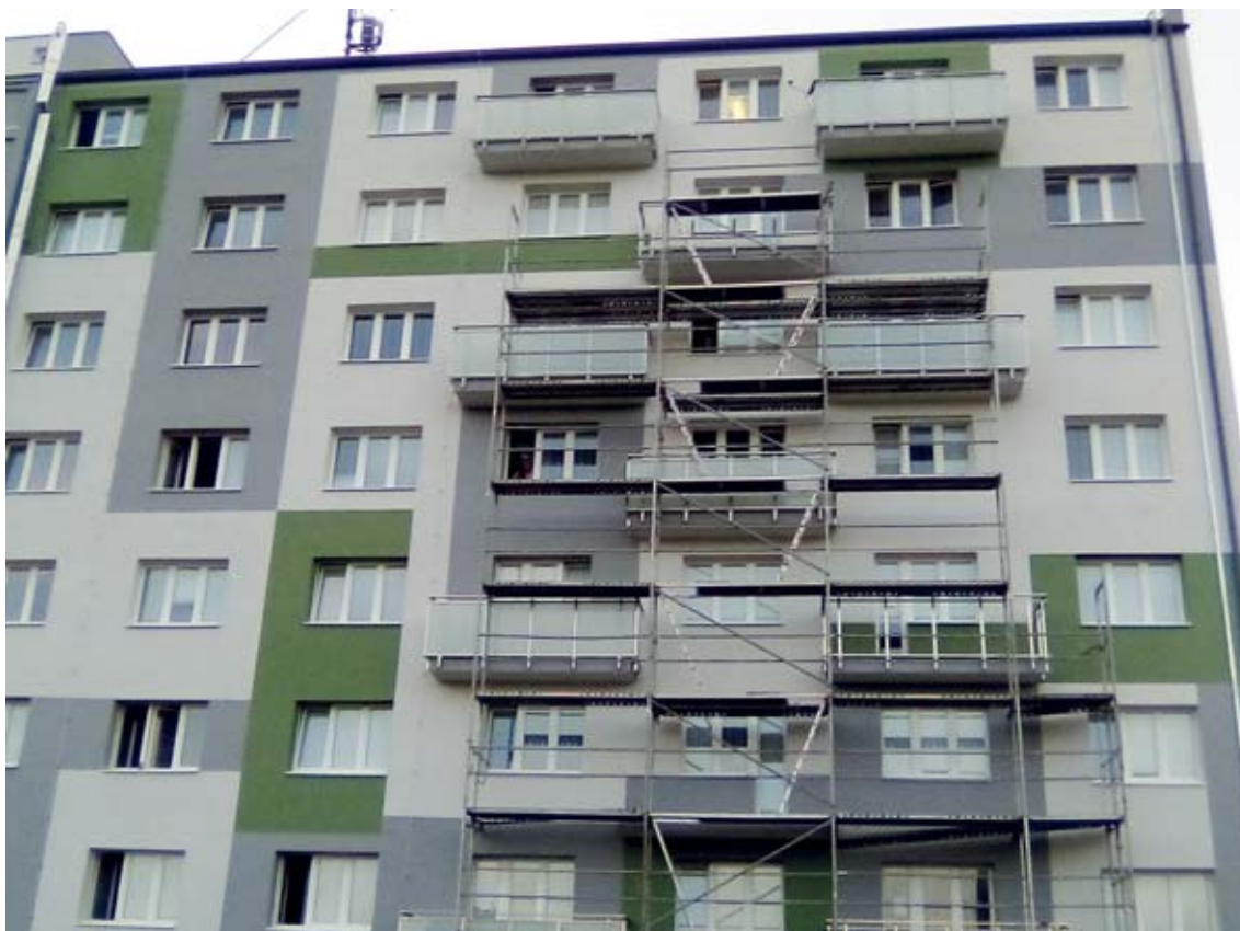
Obnova bytového domu na Nábřežnej ulici v Prievidzi začala v roku 2016. Zavŕšená bola zateplením s kolaudačným rozhodnutím o užívaní stavby vo februári 2020.
