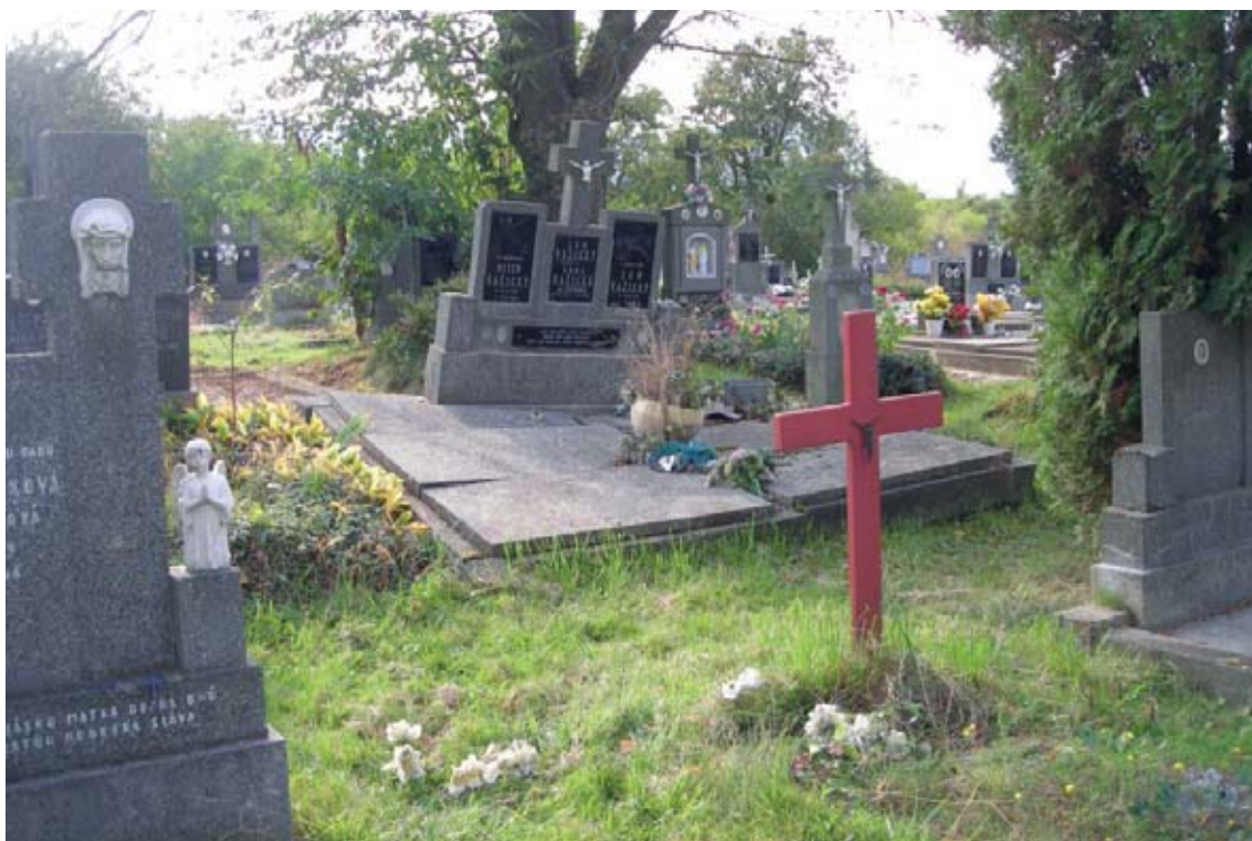
V auguste 2007 začali práce na sanácii zlomových poklesov a priehlbín na cintoríne v obci Koš, ktoré vznikli v dôsledku banskej činnosti. Projekt zahŕňal sanáciu 262 poškodených hrobov. Od augusta 2007 ich zabezpečovala Košovská stavebná spoločnosť. Prvá etapa sanačných prác bola ukončená pred Sviatkom všetkých svätých, v druhej etape sa pokračovalo v roku 2008.
