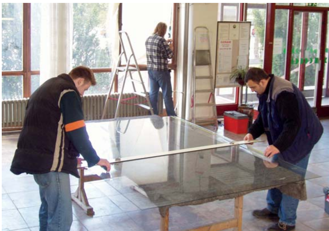
Výbuch vo Vojenskom opravárenskom podniku Nováky 2. marca 2007 spôsobil škody aj na povrchových objektoch spoločnosti.
